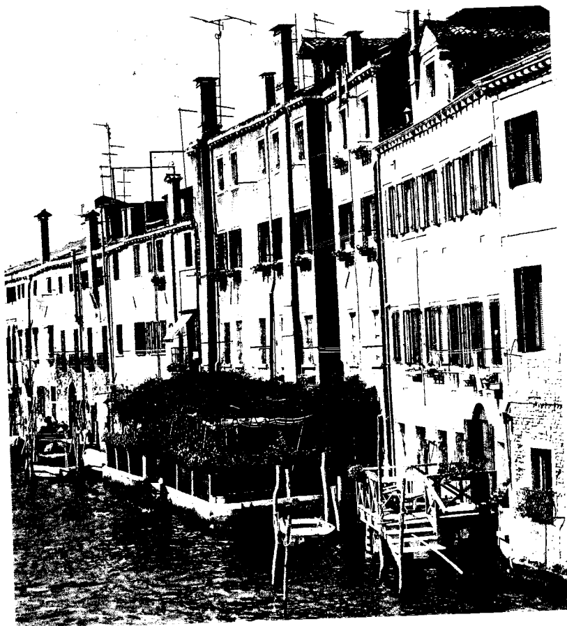
55. «Altanella» tuttora esistente nell'isola della Giudecca; espansione di un edificio abitativo con apertura sul canale presumibilmente simile a quelle costruite abusivamente in ghetto lungo i rii di perimetro.
